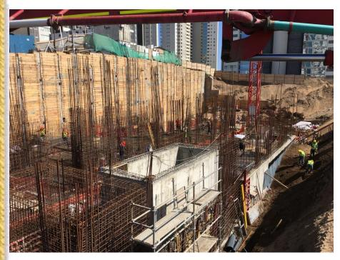
Con un 100% de avance se encuentra el refuerzo de contención de suelo mediante técnica de Pilas de Socalzado. Se avanza con pisos subterráneos superiores
