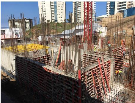
Se avanza con pisos subterráneos superiores mediante losas y muros de hormigón armado, encofrado en moldajes metálicos.
